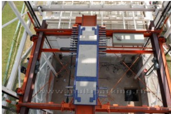
Фото 1. Центральний ліфт для швидкісного підйому автомобілів
