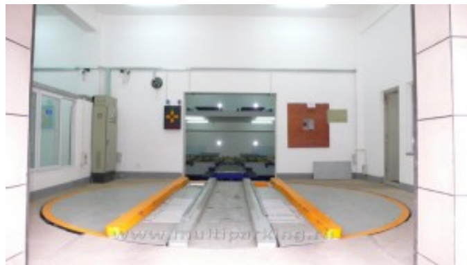
Фото 3. Кабіна в'їзду/виїзду з поворотною платформою для розвороту автомобіля
